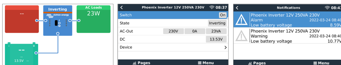
Пример экранов GX слева направо: системный экран, экран устройства инвертора и предупреждения.
